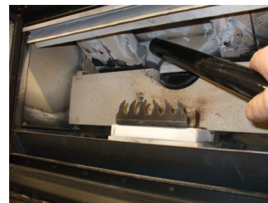
Fig. 38 - Schoonmaak bovenste deel
