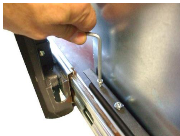
Fig. 15 - Schroef achteraan om het inbouwelement te bevestigen
