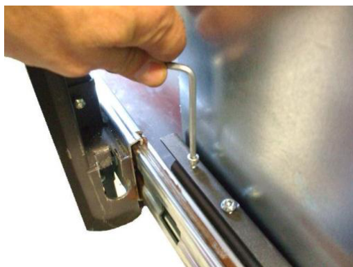
Fig. 20 - Schroef achteraan om het inbouwelement te bevestigen
