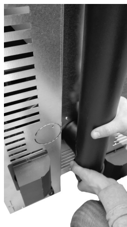
Fig. 42 - Koppel de buis met diameter 80 mm
