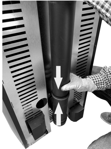
Fig. 39 - Sluit de buizen aan
