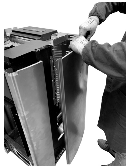
Fig. 28 - Verwijder de zijpanelen
