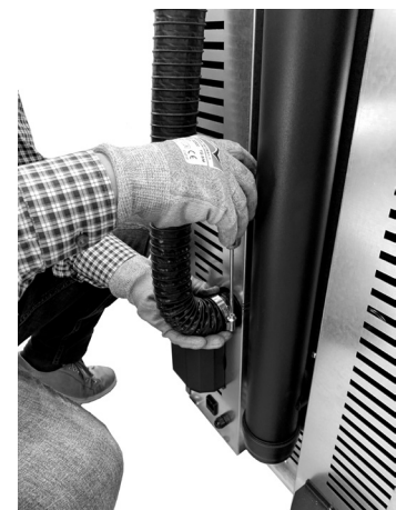
Fig. 43 - Koppel de buis van de verbrandingslucht
