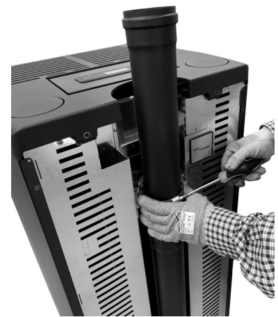
Fig. 40 - Rookgassenafvoer achteraan gemonteerd
