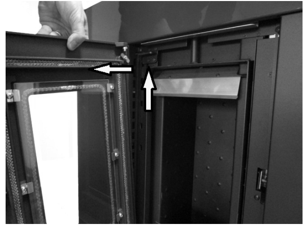
Fig. 18 - Verwijdering van de deur
