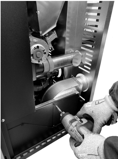
Fig. 48 - Positionering van de buizen voor kanalisering
