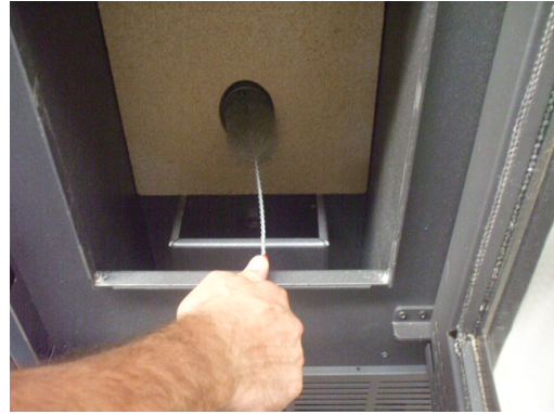
Fig. 54 - Reiniging met flessenwisser
