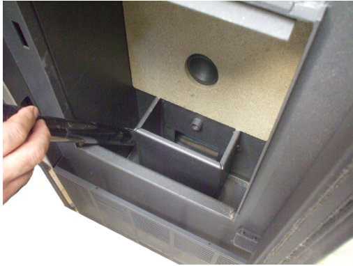
Fig. 53 - Reiniging ruimte vuurpot
