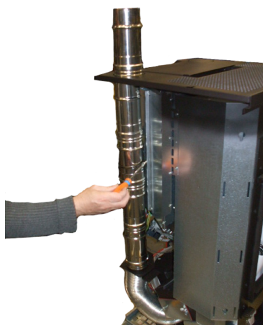
Fig. 40 - Positionering van de buizen voor kanalisering bovenaan
