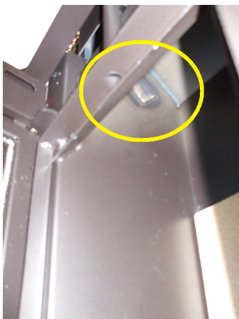
Fig. 68 - Passage van de rookgassen
