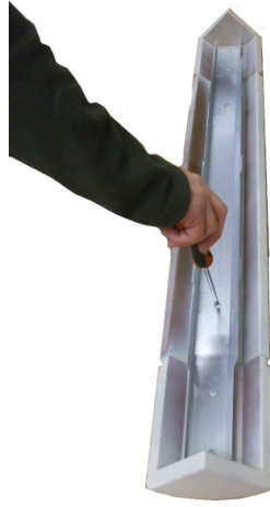
Fig. 25 - Schroef het profiel aan op de majolica's
