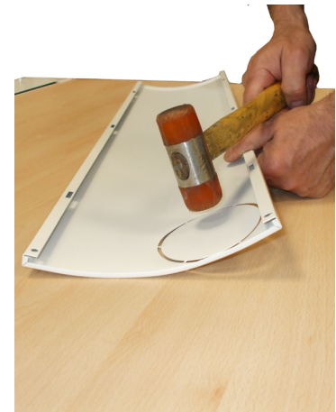
Fig. 29 - Open het gat (model Sfera 3 Plus)
