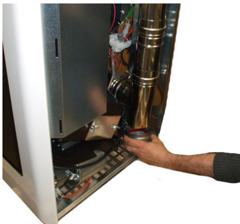
Fig. 74 - Reiniging rookleiding
