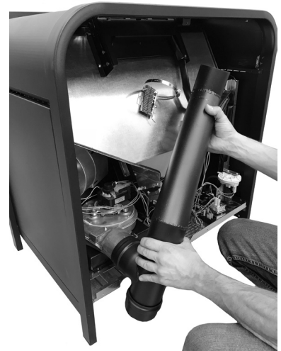
Fig. 25 - Positioneer het rookgaskanaal.
