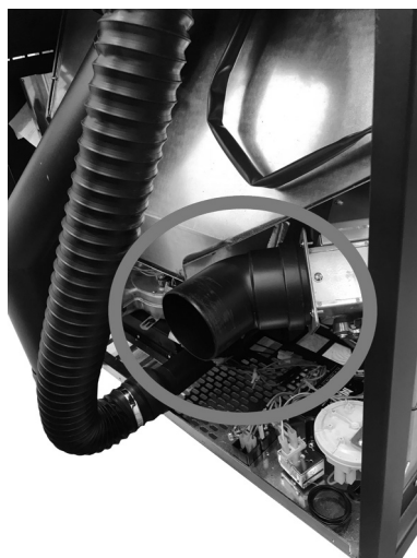
Fig. 37 - Plaats de 45° koppeling
