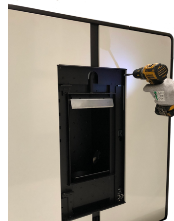
Fig. 38 - Bevestiging bekleding
