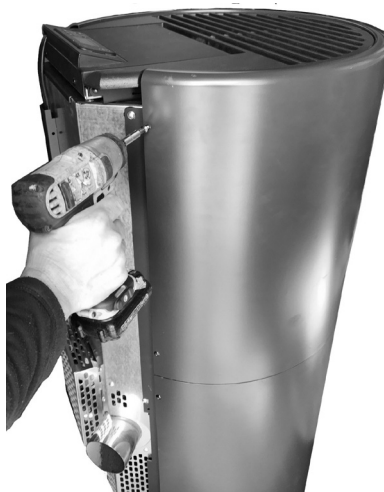
Fig. 66 - Verwijdering achterste schroeven
