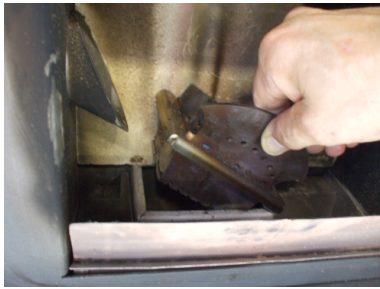
Fig. 27 - Verwijdering vuurpot
