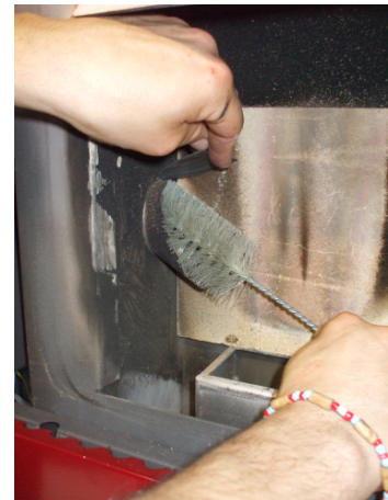
Fig. 32 - Reiniging met flessenwisser
