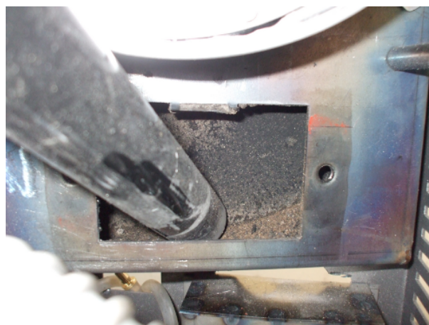
Fig. 35 - Reiniging rookgassenkamer
