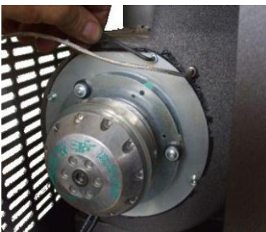
Fig. 37 - Fume fan cleaning: phase 1
