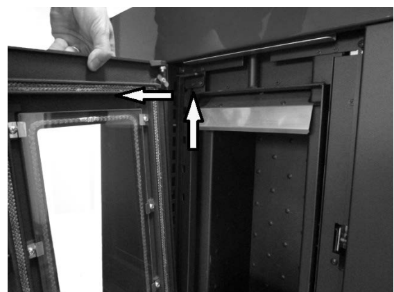
Fig. 53 - Verwijdering van de deur
