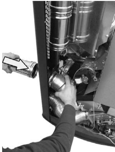
Fig. 66 - Positionering van de buizen voor kanalisering
