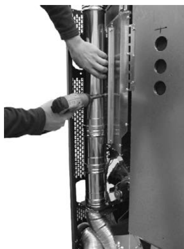
Fig. 64 - Bevestiging van de buis
