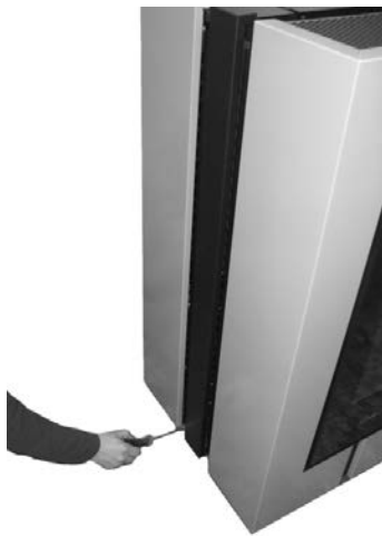
Fig. 78 - Verwijdering onderste schroeven
