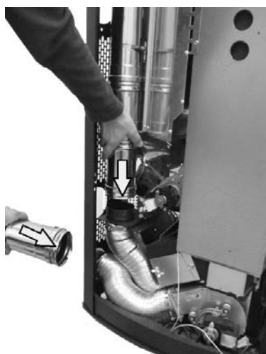
Fig. 63 - Positionering van de buizen voor kanalisering
