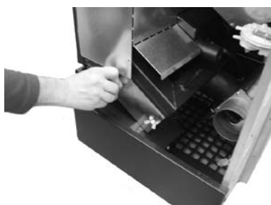
Fig. 99 - Rookgassenkamer
