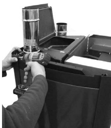
Fig. 91 - Verwijdering bovenste gebogen profielen
