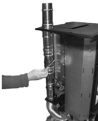
Fig. 56 - Positionering van de buizen voor kanalisering bovenaan
