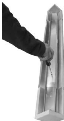
Fig. 34 - Schroef het profiel aan op de majolica's
