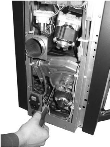
Fig. 104 - Reiniging rookgassenafzuiger: fase 1
