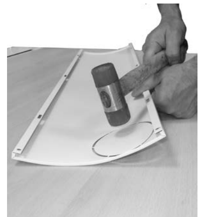
Fig. 38 - Open het gat (model Sfera 3 Plus)
