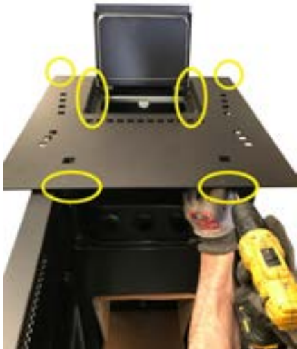
Fig. 34 - Verwijdering van de schroeven
