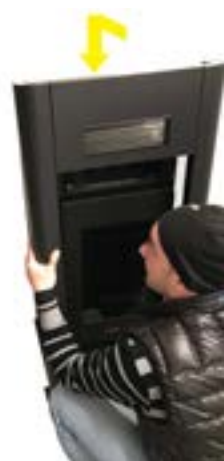
Fig. 24 - Positionering van de lijst
