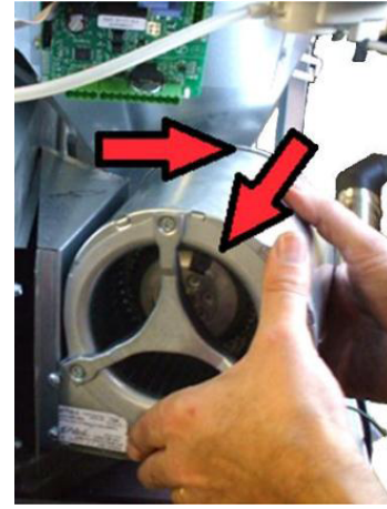
Fig. 54 - Enlevement du ventilateur
