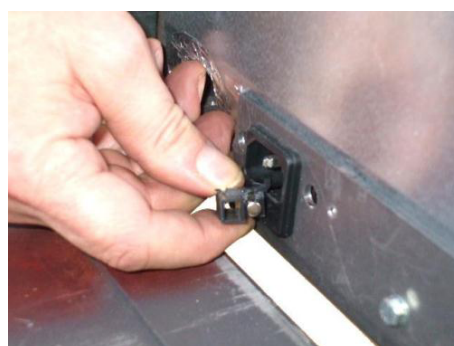
Fig. 56 - Sostituzione del fusibile
