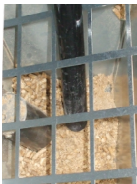
Fig. 39 - Nettoyage réservoir et vis sans fin
