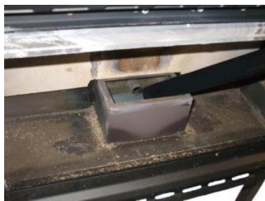
Fig. 36 - Pulizia vano braciere
