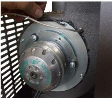
Fig. 42 - Nettoyage de l'aspirateur des fumées: phase 1
