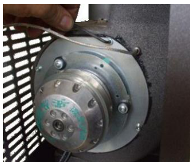
Fig. 42 - Pulizia aspiratore fumi: fase 1
