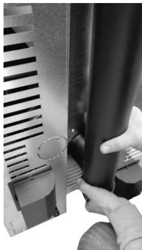
Fig. 64 - Raccorder le tuyau d.80 mm
