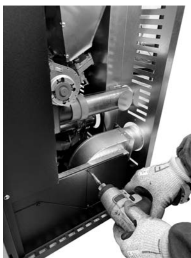
Fig. 70 - Positionnement des tuyaux pour la canalisation
