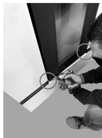
Fig. 53 - Fixer le panneau inférieur
