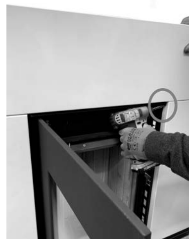
Fig. 50 - Fixer le panneau supérieur
