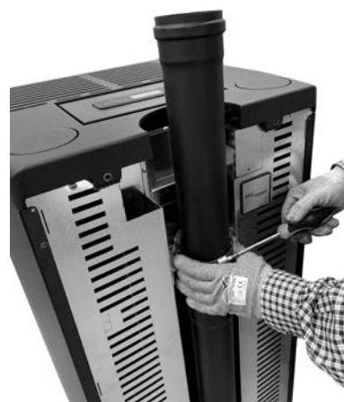
Fig. 62 - Conduit arrière d'évacuation des fumées monté
