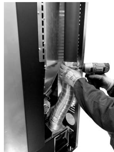
Fig. 74 - Fixer les tuyaux
