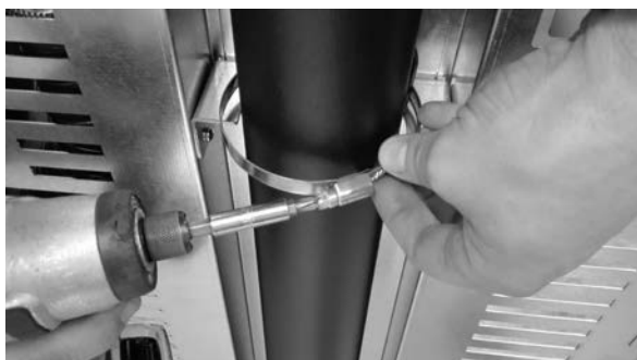
Fig. 66 - Bloquer avec un collier de serrage
