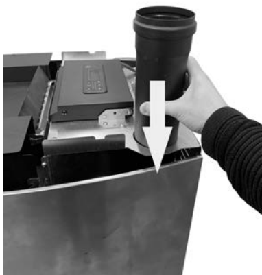
Fig. 72 - Introduire le tuyau
