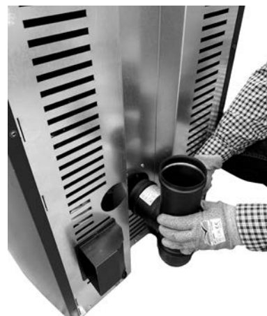
Fig. 59 - Raccorder le raccord en T
