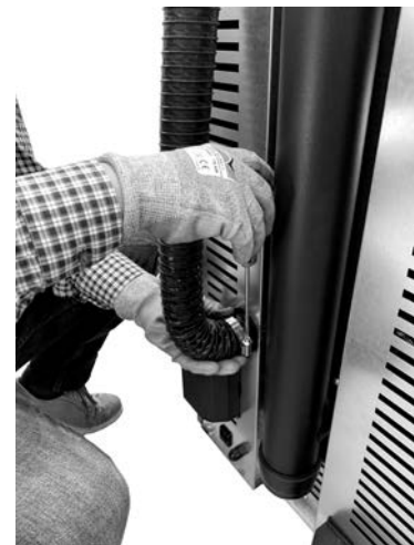
Fig. 65 - Raccorder le tuyau de l'air comburant
