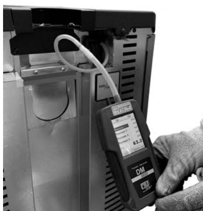
Fig. 97 - Connexion du pressostat numérique (Atena 3 Plus12/14 - Duke 12/14 At - Saba 12/14)
