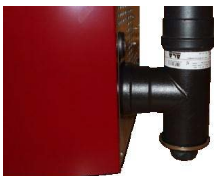
Fig. 62 - Reiniging rookleiding
