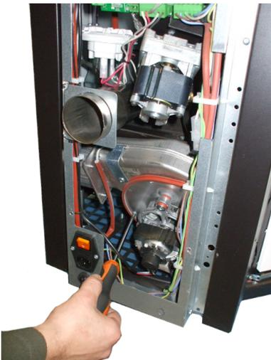
Fig. 76 - Nettoyage de l'aspirateur des fumées: phase 1
