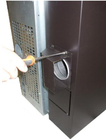
Fig. 45 - Montage du diffuseur
