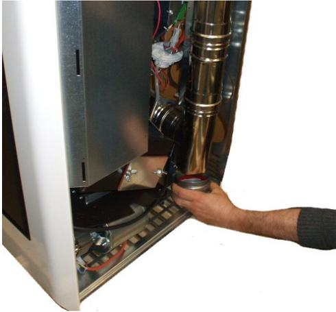
Fig. 74 - Nettoyage du collecteur des fumées
