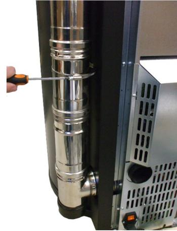
Fig. 75 - Collecteur des fumées (Sfera³ Plus, Sfera³, Globe, Elise³ Plus)
