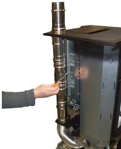
Fig. 40 - Positionnement des tubes supérieurs
