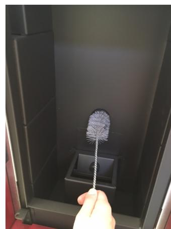
Fig. 43 - Nettoyage avec nettoie-pipes
