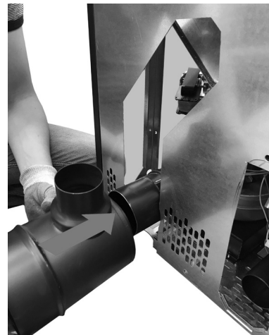
Fig. 51 - Raccorder le tuyau concentrique
