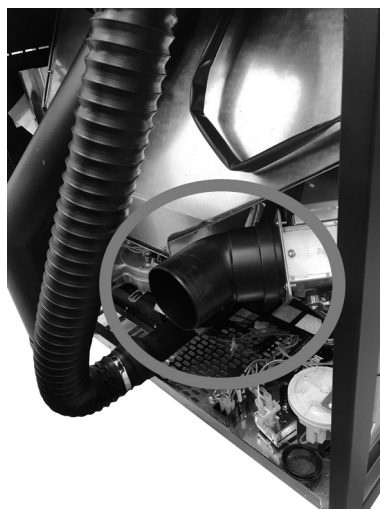
Fig. 46 - Placer le raccord à 45°
