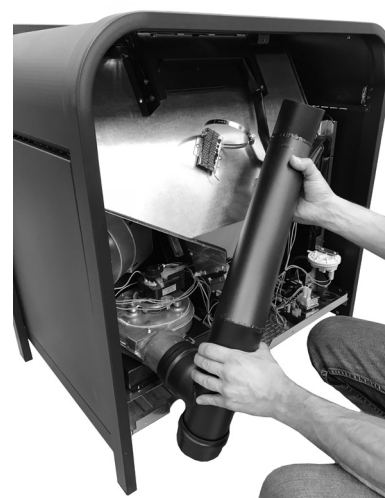
Fig. 34 - Placer le tuyau d'évacuation des fumées
