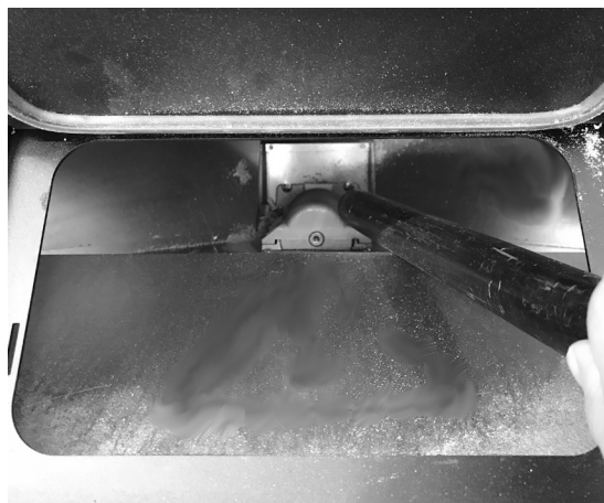
Fig. 30 - Nettoyage réservoir et vis sans fin
