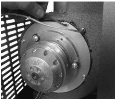
Fig. 59 - Nettoyage de l'aspirateur des fumées: phase 1
