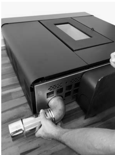
Fig. 48 - Canalisation 1
