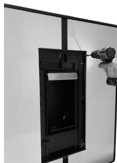
Fig. 46 - Fixation du revêtement
