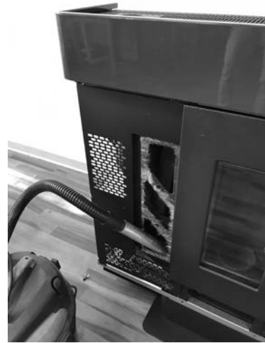
Fig. 33 - Nettoyage de la chambre des fumées
