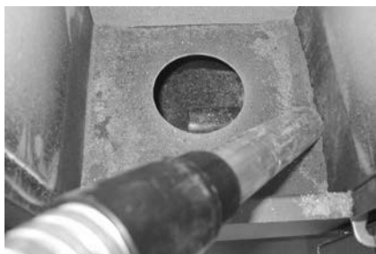
Fig. 26 - Nettoyage l'espace du tiroir à cendre
