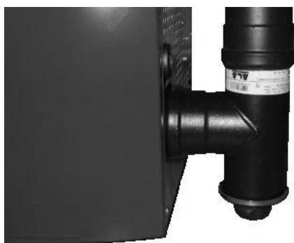
Fig. 87 - Nettoyage du conduit de fumée
