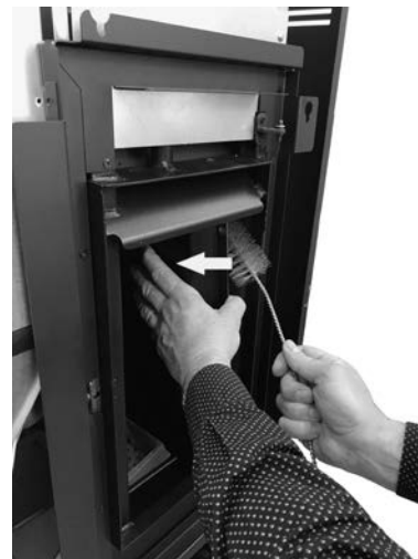
Fig. 77 - Nettoyer avec un goupillon
