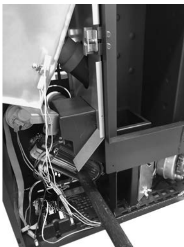
Fig. 78 - Nettoyage de le ventilateur ambiant
