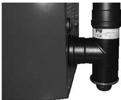
Fig. 72 - Nettoyage du conduit de fumée
