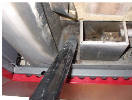
Fig. 31 - Nettoyage l'espace du tiroir à cendre
