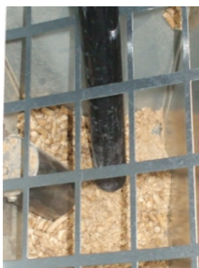
Fig. 33 - Nettoyage réservoir et vis sans fin
