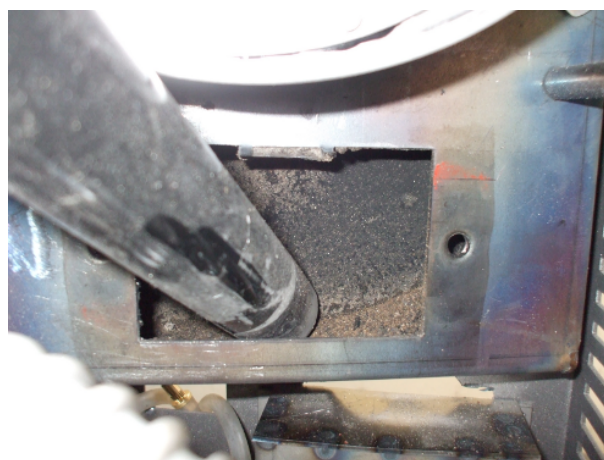
Fig. 35 - Nettoyage de la chambre des fumées
