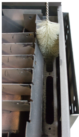
Fig. 43 - Nettoyage du canal
