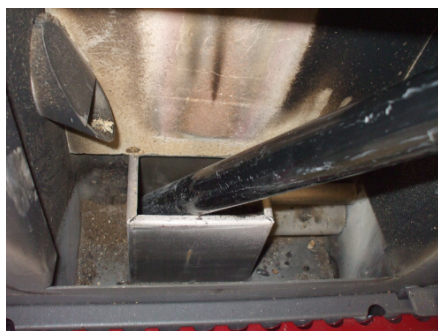
Fig. 30 - Nettoyage l'espace du brasero
