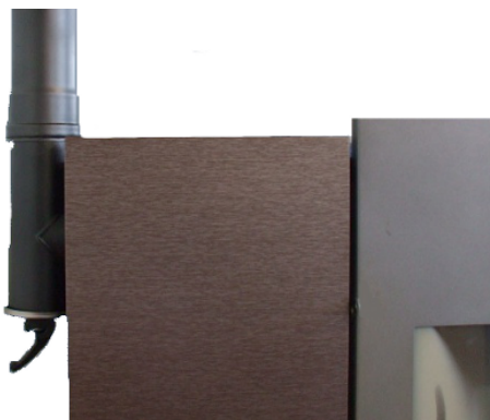
Fig. 36 - Pulizia canale da fumo
