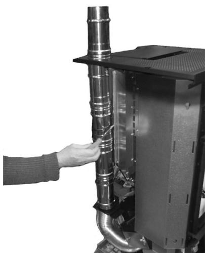
*Fig. 70 - Positionnement des tubes supérieurs*
