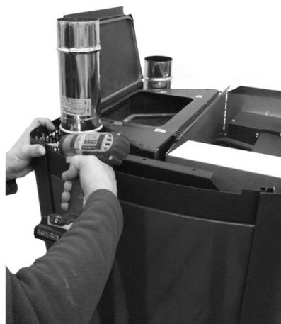
*Fig. 61 - Repositionnement des profilés courbés supérieurs*
