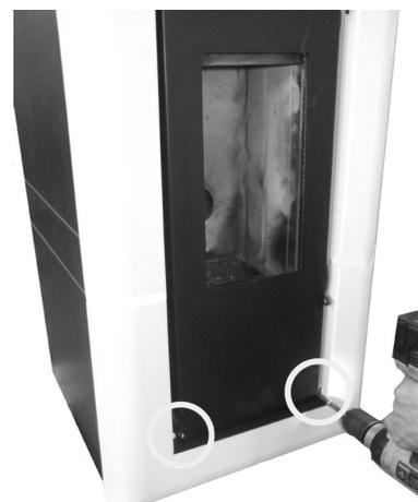
Fig. 46 - Fixation du panneau frontal
