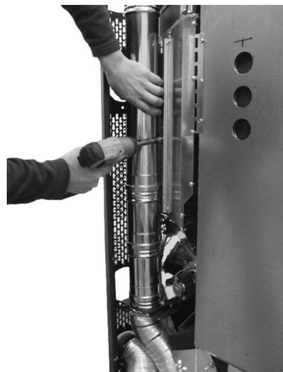
**Fig. 78 - Fixation du tuyau**
