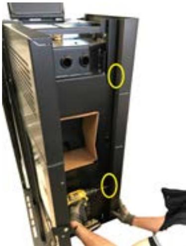
Fig. 35 - Fixation avant du panneau latéral
