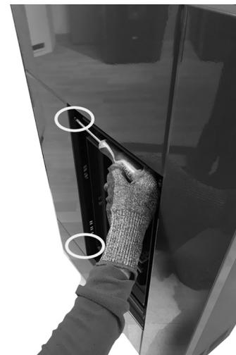
*Fig. 27 - Fixation des vis*
