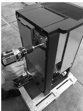
Fig. 34 - Verwijder het zwarte profiel
