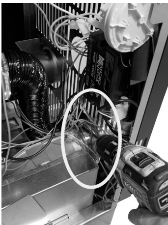
Fig. 60 - Flexibele buis vastzetten
