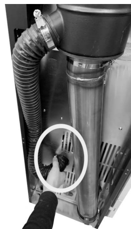
Fig. 50 - Flexibele buis invoegen
