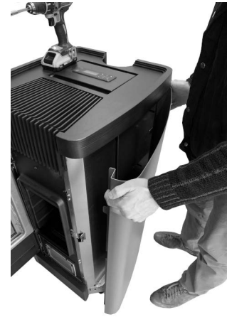
Fig. 30 - Zijpaneel verwijderen
