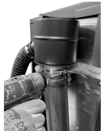
Fig. 48 - Vastzetten met buisklem
