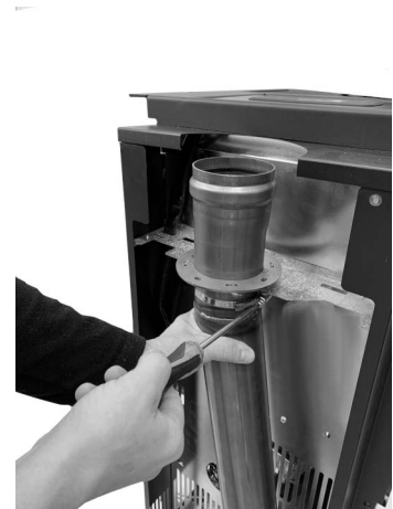
Fig. 42 - Vastzetten met buisklem
