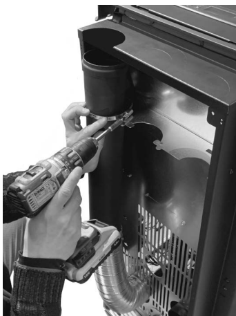
Fig. 63 - Buis met diam. 80 mm vastzetten
