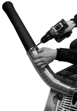
Fig. 61 - Buis met diam. 80 mm aansluiten
