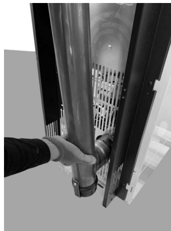
Fig. 41 - Buis met diam. 80 mm aansluiten
