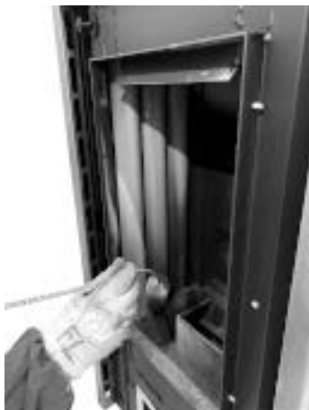
Fig. 81 - Reinig met pijpenwisser
