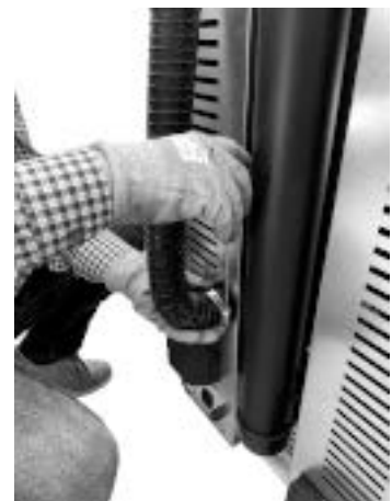
Fig. 51 - Koppel de buis van de verbrandingslucht
