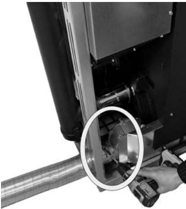
Fig. 60 - Flexibele buis vastzetten
