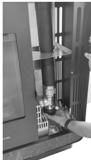
Fig. 73 - Nettoyage du conduit de fumée
