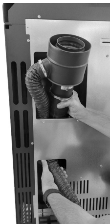
Fig. 46 - Buis met diam. 80 mm aansluiten
