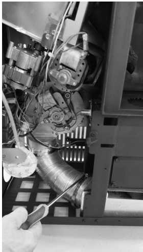
Fig. 38 - Schroef de buisklem los 1
