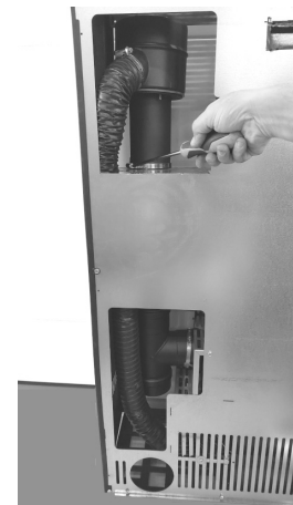
Fig. 47 - Vastzetten met buisklem
