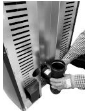
Fig. 65 - Raccorder le raccord en T
