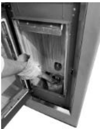
Fig. 35 - Nettoyage l'espace du brasero
