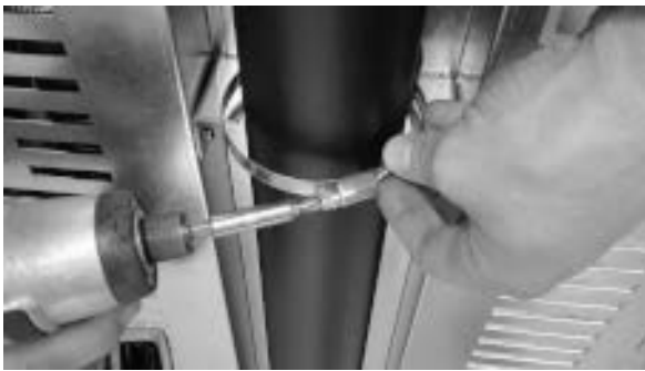
Fig. 63 - Blokkeer met klem
