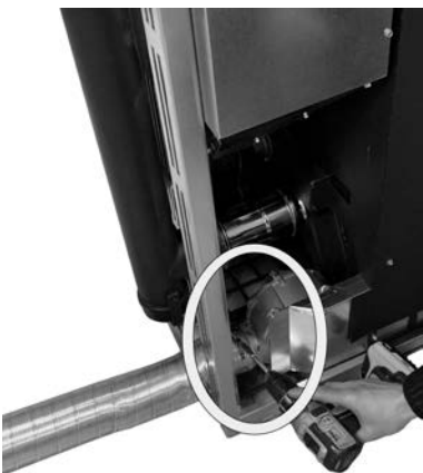
Fig. 71 - Flexibele buis vastzetten
