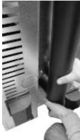
Fig. 61 - Koppel de buis met diameter 80 mm
