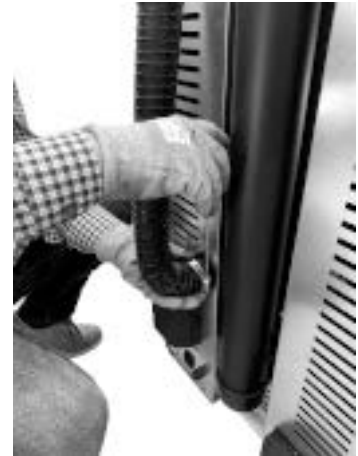
Fig. 62 - Koppel de buis van de verbrandingslucht
