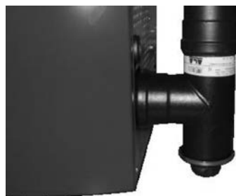
Fig. 86 - Reiniging rookleiding
