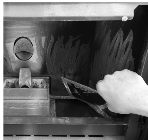
Fig. 25 - Verwijder de inspectiedop
