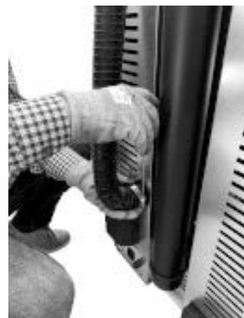
Fig. 71 - Raccorder le tuyau de l'air comburant
