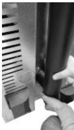
Fig. 70 - Raccorder le tuyau d.80 mm
