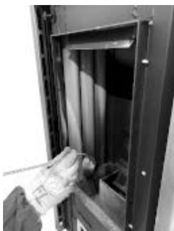
Fig. 101 - Nettoyer avec un goupillon
