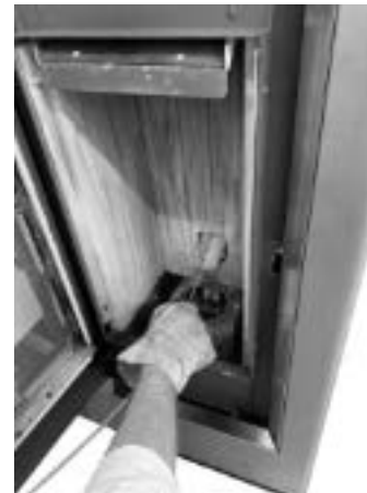
Fig. 36 - Reiniging met flessenwisser
