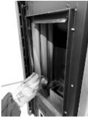
Fig. 92 - Reinig met pijpenwisser
