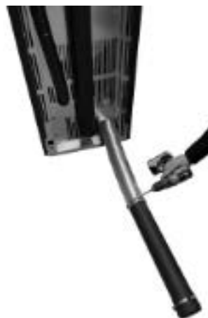
Fig. 72 - Buis met diam. 80 mm aansluiten
