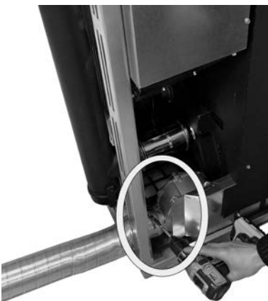
Fig. 71 - Flexibele buis vastzetten
