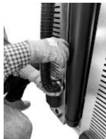
Fig. 62 - Koppel de buis van de verbrandingslucht
