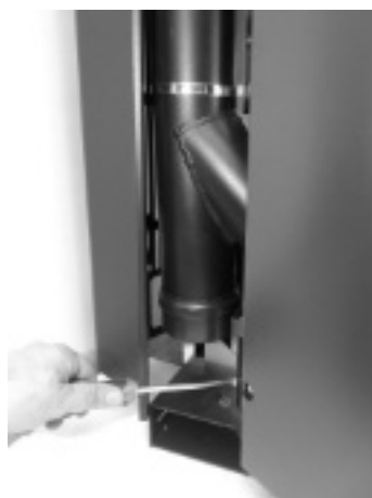
Fig. 75 - Dévisser le dispositif de blocage du bouchon
