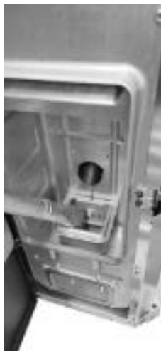
Fig. 39 - Nettoyage l'espace du brasero
