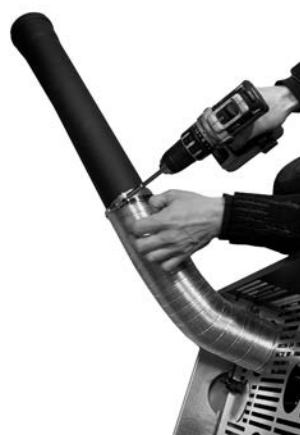
Fig. 70 - Raccorder le tuyau d.80 mm
