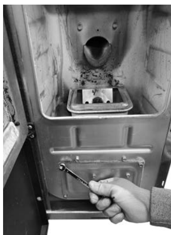
Fig. 83 - Retirer les vis
