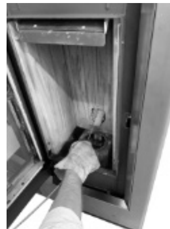
Fig. 35 - Reiniging met flessenwisser
