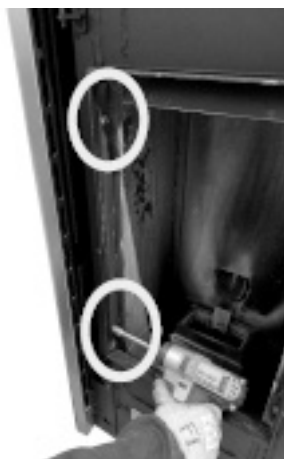
Fig. 46 - Verwijder de zeskantschroeven
