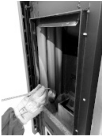
Fig. 51 - Reinig met pijpenwisser
