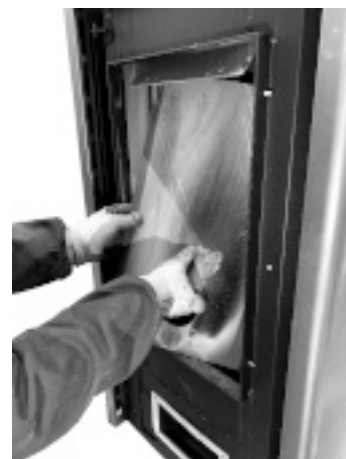
Fig. 50 - Verwijder het achterpaneel van de vuurhaard
