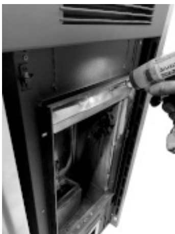
Fig. 45 - Verwijder de deflector
