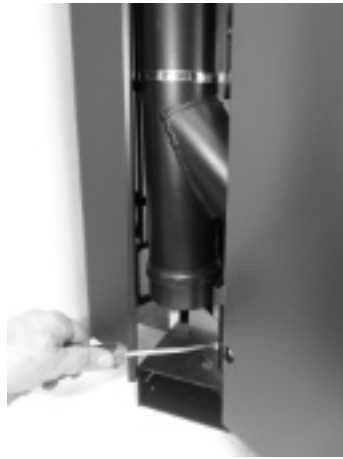
Fig. 74 - Dévisser le dispositif de blocage du bouchon
