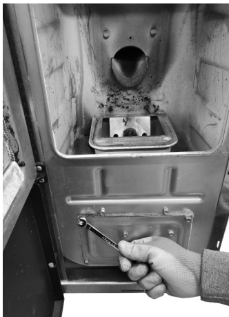
Fig. 76 - Retirer les vis
