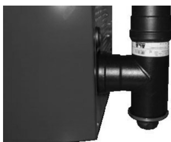
Fig. 72 - Nettoyage du conduit de fumée
