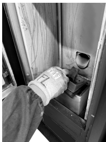
Fig. 33 - Verwijdering vuurpot
