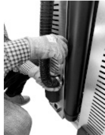
Fig. 28 - Koppel de buis van de verbrandingslucht
