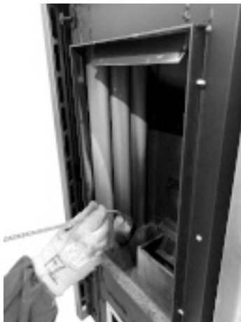
Fig. 60 - Reinig met pijpenwisser
