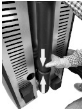
Fig. 24 - Sluit de buizen aan
