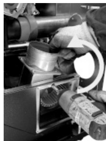
Fig. 35 - Draai ventilator
