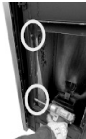
Fig. 55 - Verwijder de zeskantschroeven
