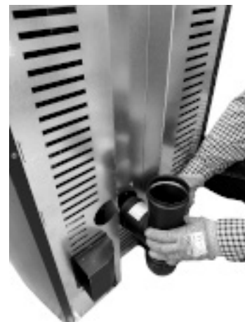
Fig. 22 - Sluit een T-aansluiting aan
