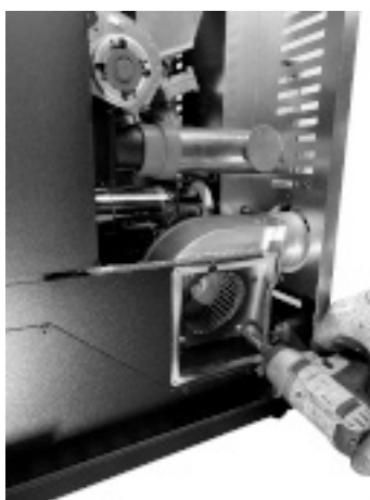
Fig. 34 - Bevestiging van de buis
