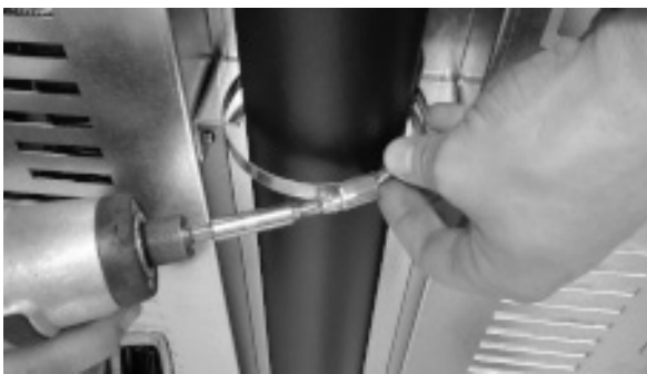
Fig. 29 - Blokkeer met klem
