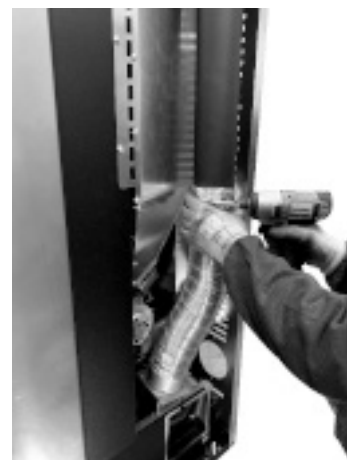
Fig. 38 - Bevestig de buizen
